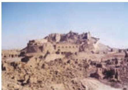
ج) ارگ بم بعد از زلزله
