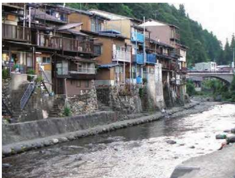
شکل ۱۴- عدم رعایت حریم آب
