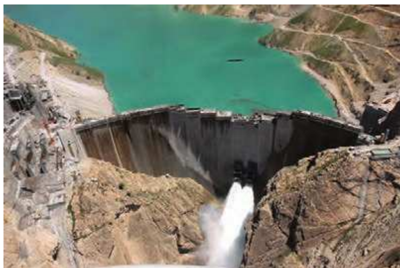
شکل ۵- سد کارون (۴) - خوزستان
