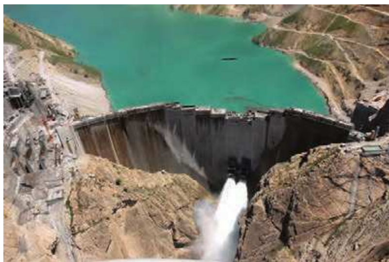
شکل ۵- سد کارون (۴) - خوزستان
