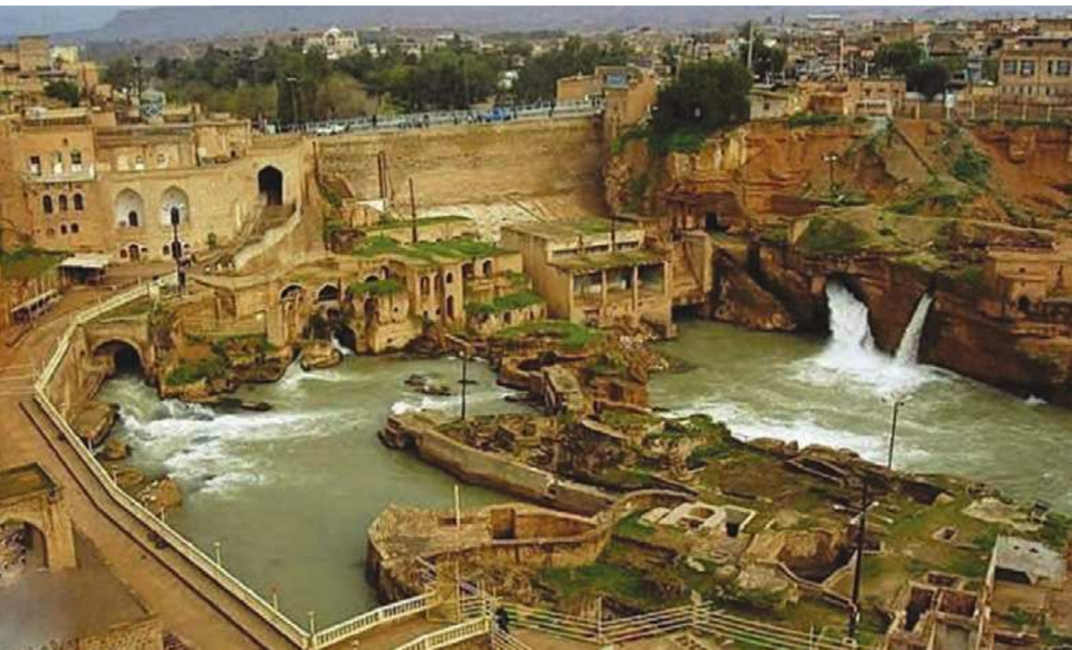
شکل ۵- سازه‌های آبی - تاریخی، شوشتر، خوزستان
