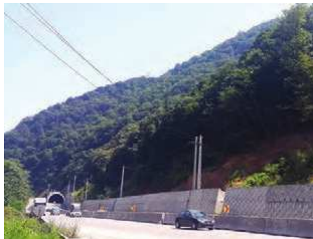
نصب حفاظ بتونی - جاده قائم‌شهر
