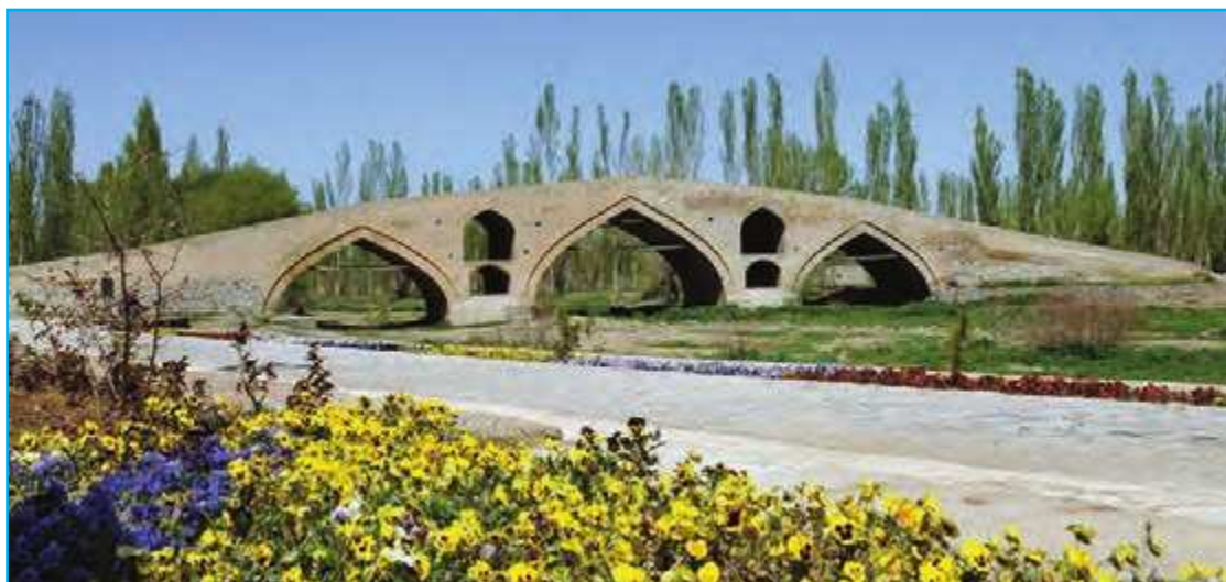
پل میرزاالحین بر روی رودخانه زنجانرود
