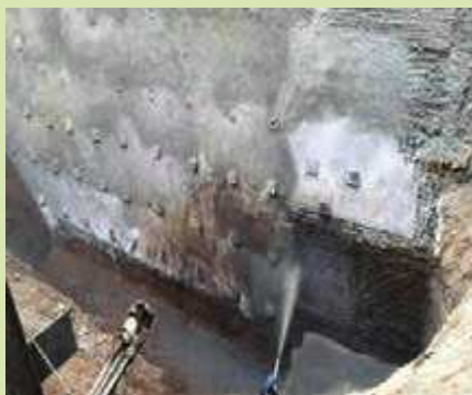
پایدارسازی شیب به روش میخ کوبی
