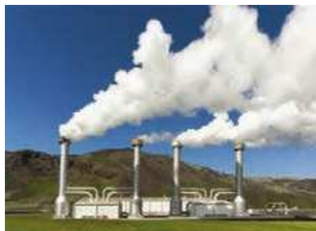
شکل ۱۱-۶- نیروگاه زمین گرمایی مشکین شهر - اردبیل
