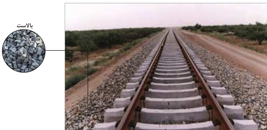
شکل ۴-۱۱-بالاست در زیرسازی جاده ریلی
