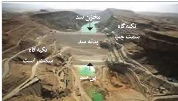
شکل ۵-۴- نمایی از بخش‌های مختلف یک سد
